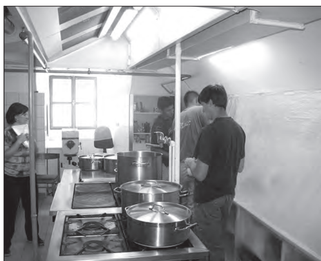
Bílění kuchyně a skladů, které jsou součástí jídelny v zámku.
