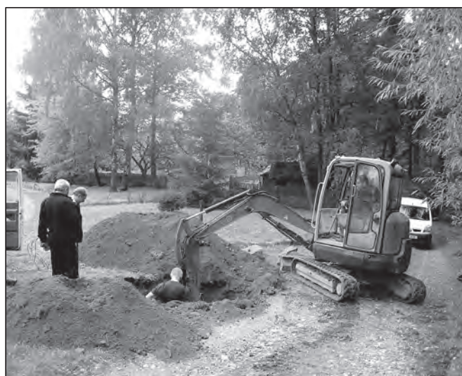
Výměna vodovodního uzávěru pod vodojemem.
