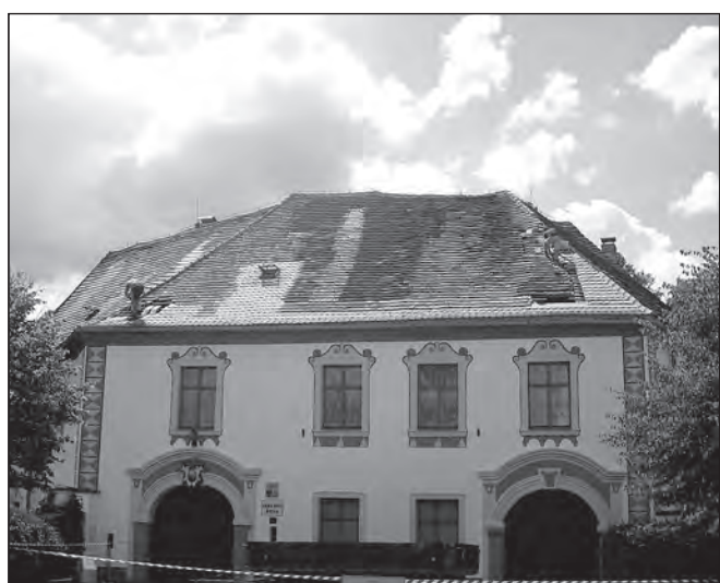
Údržba střechy chanovického zámku v srpnu tohoto roku.
