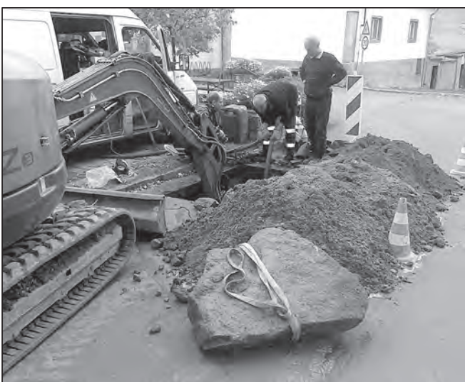
Oprava prasklého vodovodního potrubí u úřadu.
