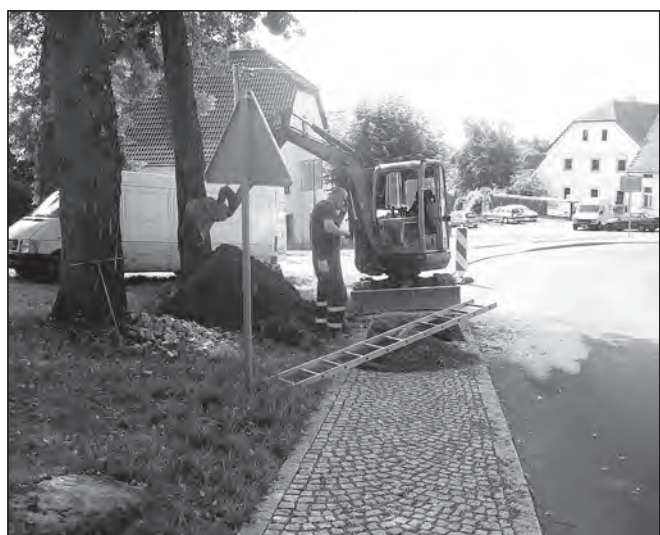
Oprava prasklého vodovodního potrubí nad návší.
