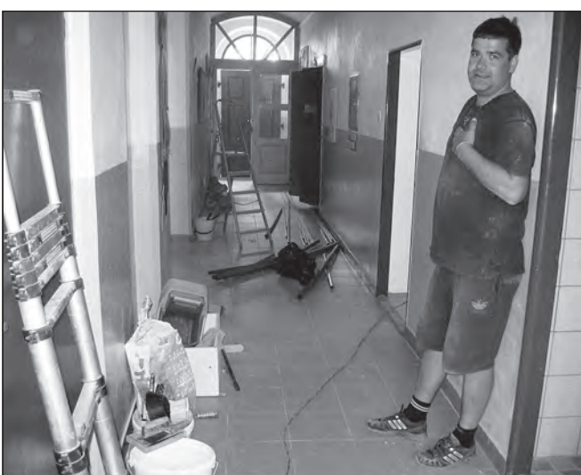
Ústřední topení v budově prvního stupně základní školy je nové.
