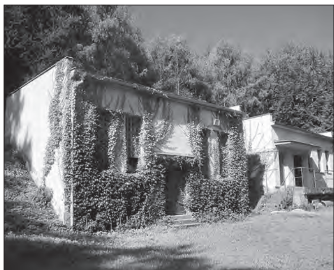
Vodojem pro čtyři vesnice má opravenou střechu a natřené oplocení.
