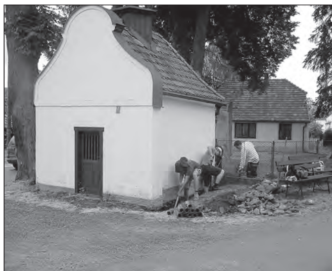
Brigádníci pracují na odvodu vlhkosti u kapličky v Holkovících.
