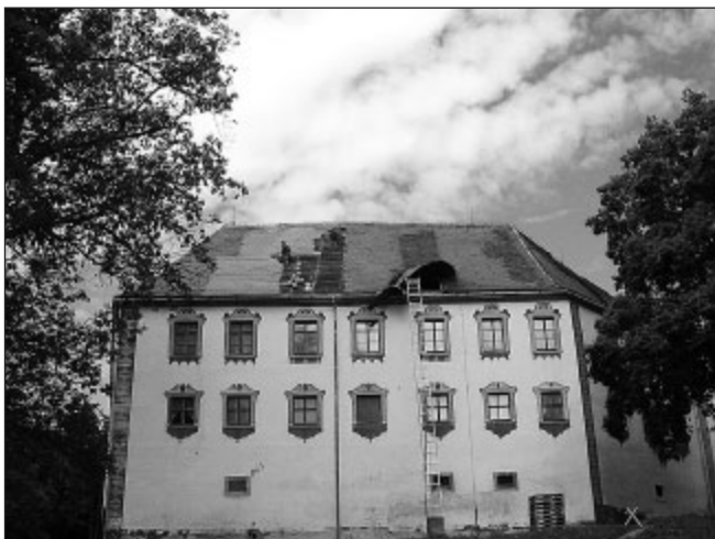
Oprava střechy zámku.
