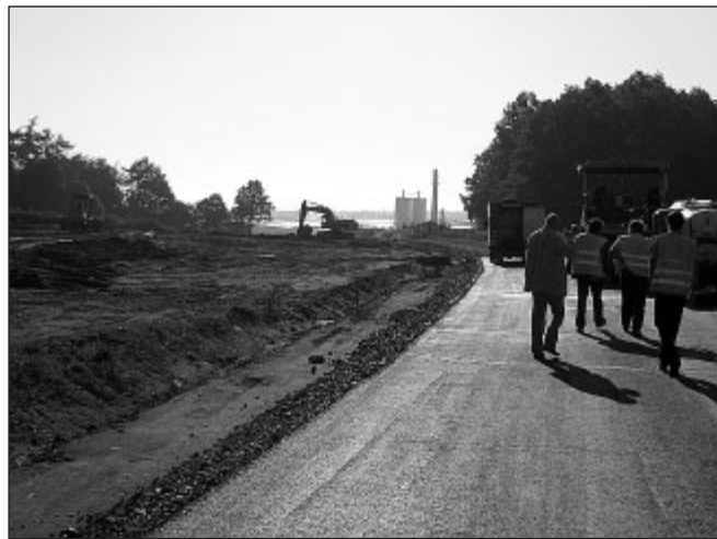
Stavba nové silnice.
