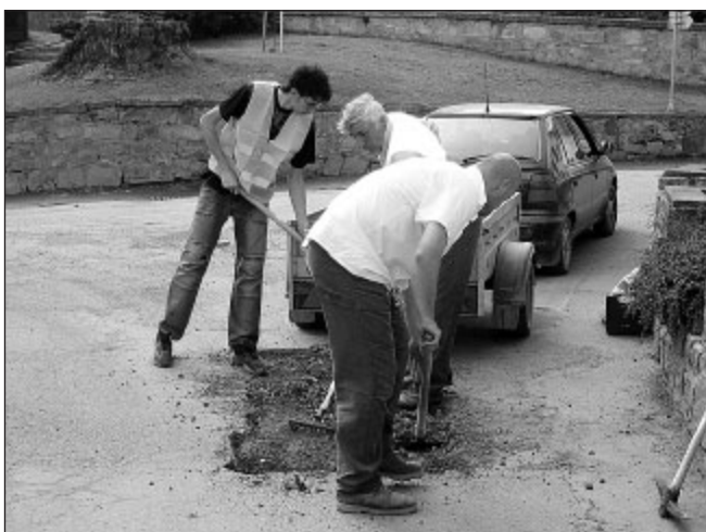
Jarní oprava cest.
