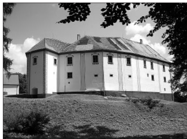
Oprava fasády zámku.
