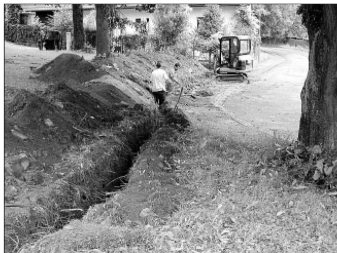
Pokládka elektro do země.
