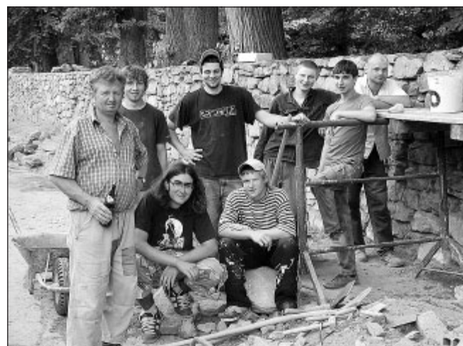
Oprava zámecké kamenné zdi s brigádníky.
